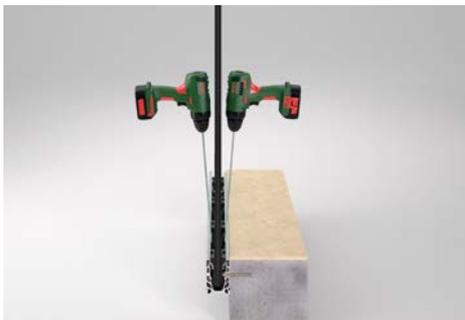
**4** Stellen Sie die Neigung der Glasscheibe mit den Schrauben an den Klammern ein und ziehen Sie sie fest.
