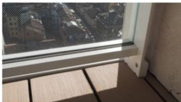
Dettaglio di Modular SP di Alu vetro, nella versione customizzata sviluppata per Torre Milano con lastre di vetro serigrafato con una trama puntinata
