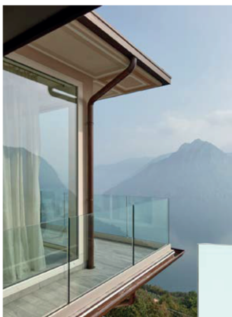
Garda One prevede il fissaggio sopra pavimento e l'installazione dal lato interno
